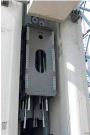
↑ Stalen eindstuk contragewicht met trekstangen
